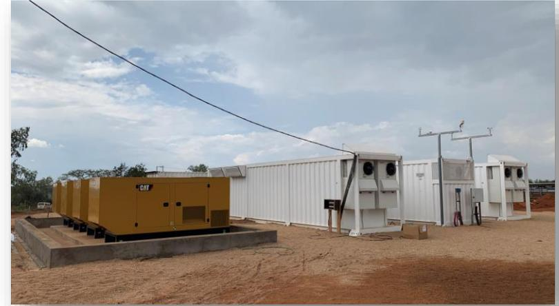
REMOTE GROUP – Ruanda: Smart Microgrid per Campus RICA a Kigali: Sistema Ibrido PV 1,5 MWp - Diesel 1,6 MW - ES 3 MWh
