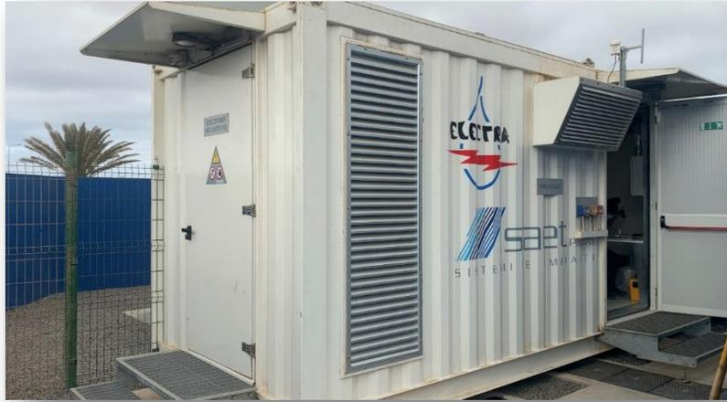
ELECTRA – Capo Verde: sistema di accumulo da 1MW/1MWh con funzione di riserva energetica per aumentare la produzione del parco eolico dell'isola di Sal
