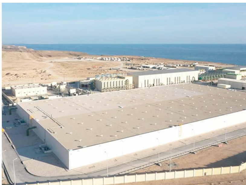
Impianto di dissalazione di Salalah – Oman, realizzato dalla Fisia Italimpianti e in operazione dal 2021.
