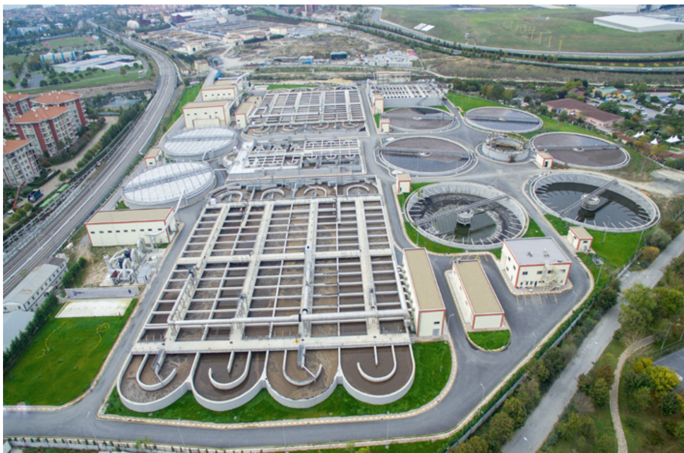
Atakoy WWTP (Fisia & Alkatas, s.d.)
