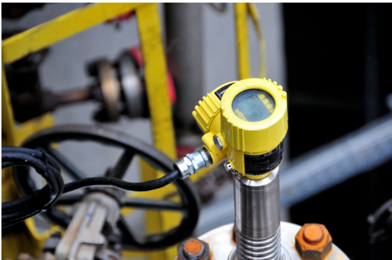
Trasmettitore radar a onde guidate "VEGAFLEX 86" (©Riccardo Parigi - Must Srl)
