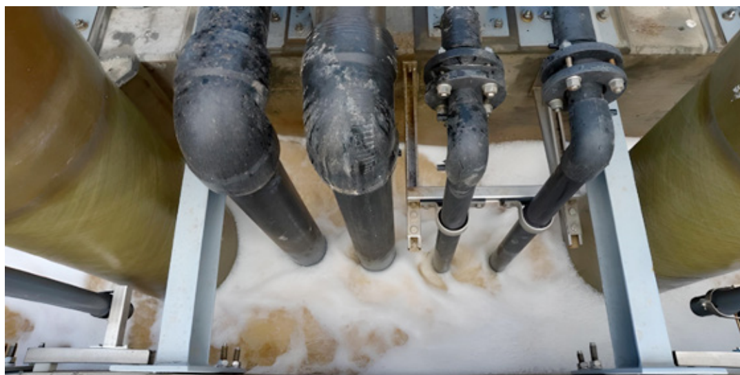
Foto 2 - Scarico della salamoia derivante dal processo di desalinizzazione in un impianto in Arabia Saudita
