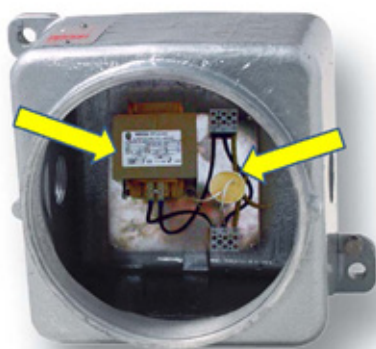
Figura 3: Indicati con delle frecce degli esempi di dispositivi a standard industriale in una custodia "Ex d"
