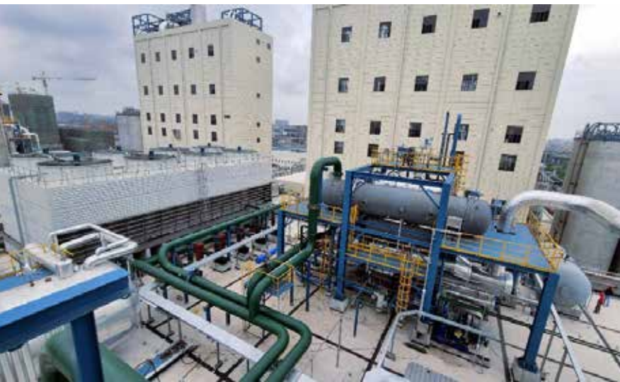
Fig. 5 – Impianto ORC per il recupero di calore nello stabilimento di Sanfame
