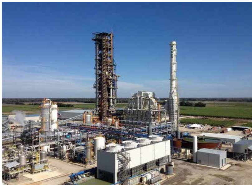
Impianto DRI di riduzione diretta in USA, per successiva produzione di acciaio al forno elettrico, con maggiore efficienza, consumi energetici e impatto ambientale ridotti
