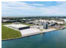
Nuovo sito produttivo di SIAD Macchine Impianti a Marghera, Venezia.
