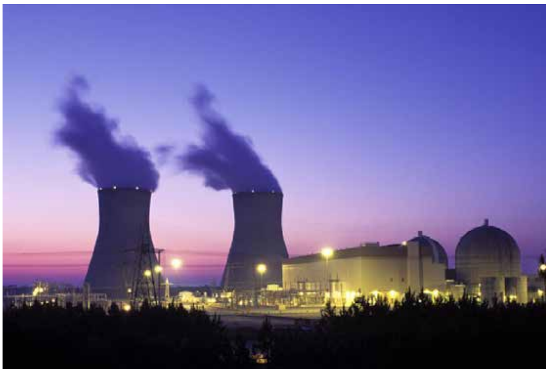
Impianto nucleare di Vogtle (Wikipedia)
