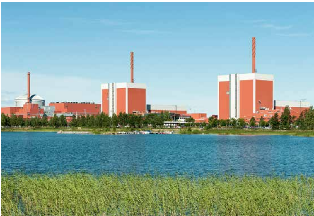
Impianto nucleare di Olkiluoto (Wikipedia)
