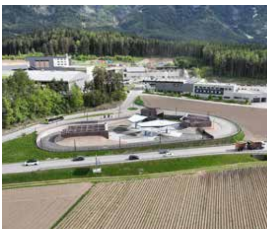
Stazione di rifornimento ad idrogeno (HRS) di Brunico (BZ) di proprietà di Alperia costruita con fondi PNRR nel 2025
