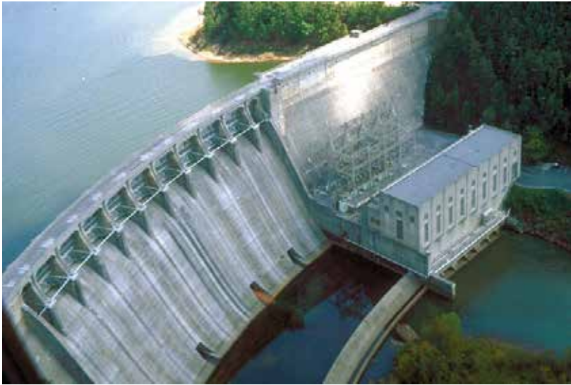
Diga per la produzione di energia idroelettrica
