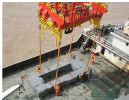
Fig. 6 - Sollevamento, a mezzo di gantry crane portuale (usata per il carico di container standard), di un collo di 111 t direttamente da barge ormeggiata lungo la murata della nave portacontainer
