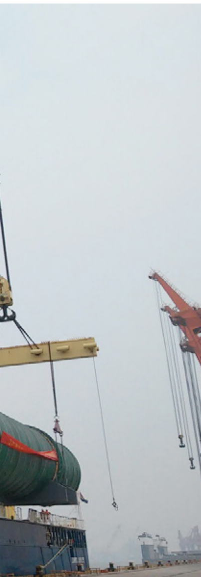
A seguire una serie di foto dell'SSP Reactor x 2 – each cm 8500 x 700 x 705 lwh – 550000 kg from Gangxin to Corpus Christi on Mv Jumbo Jubilee
