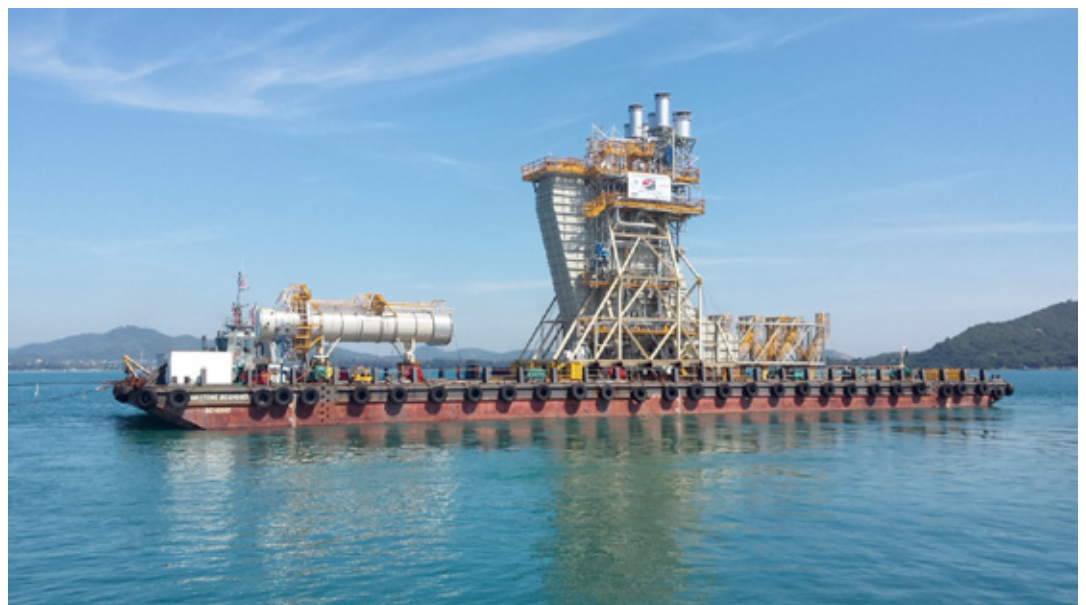
HRSG Module and Stack loaded on the barge
