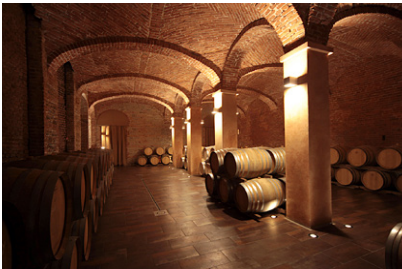
Fig. 1 – Vista parziale delle cantine sotterranee della F.lli Gancia
