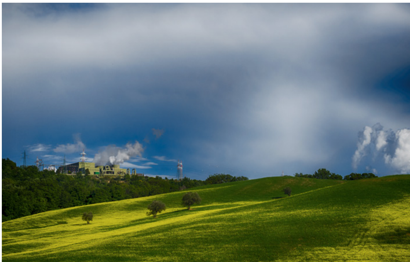
L'impianto geotermico di Nuova San Martino, a Monterotondo Marittimo (GR) nell'area geotermica Larderello-Val di Cornia, è composto da due gruppi da 20 MW, raffreddati con torri di evaporazione a tiraggio forzato, in esercizio dal 2005
